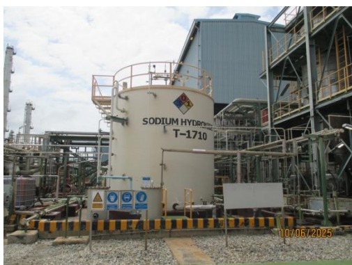
รูปที่ 3-15 เขื่อน (Curb) ล้อมรอบพื้นที่เก็บ และ การสูบน้ำสารเคมี และบริเวณพื้นที่การผลิต
