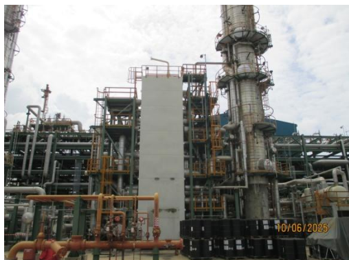
รูปที่ 3-50 Concrete Fireproofing
