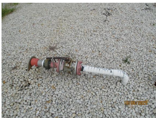
รูปที่ 3-57 Water Curtain ระหว่าง หน่วยผลิตไฟฟ้าและพื้นที่ถังเก็บสารเคมี
