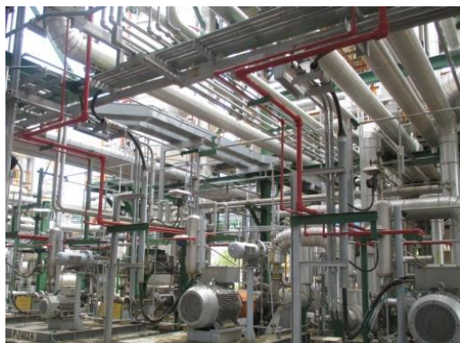
ระบบสเปรย์น้ำ (Water Spray System)
