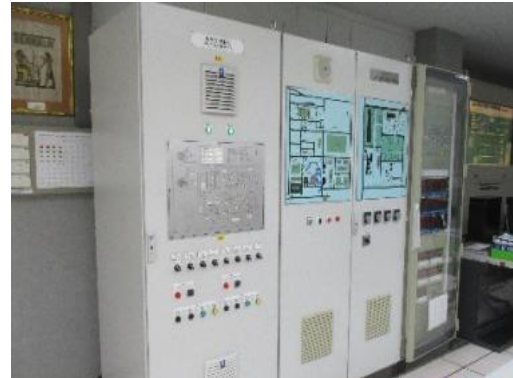
รูปที่ 3-60 ระบบตรวจสอบอัตราการไหลและความดันก๊าซ
