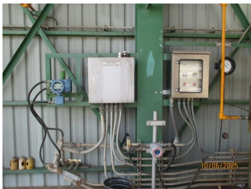
รูปที่ 3-65 Chlorine Gas Detector
