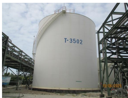
รูปที่ 3-20 Condensate Storage Tank
