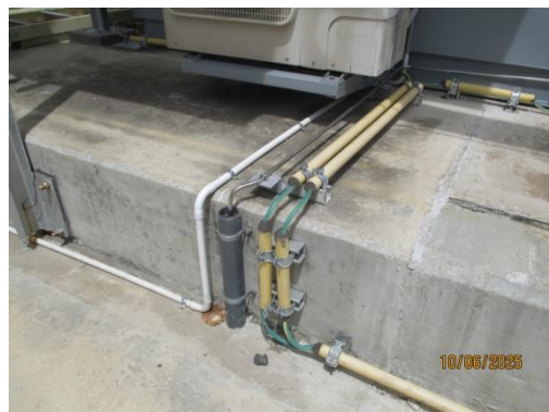
รูปที่ 3-51 ระบบ Grounding
