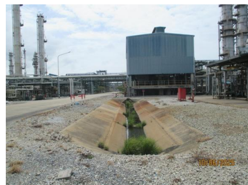
รูปที่ 3-16 รางระบายน้ำฝนทั่วไป แยกจากจุดรับน้ำฝนปนเปื้อน
