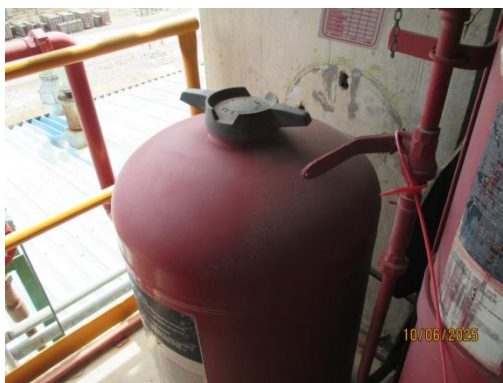
เครื่องดับเพลิงชนิด Fixed Dry Chemical
